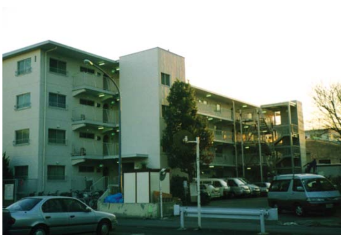
▲改修後(写真右奥に増設されたエレベーター)
