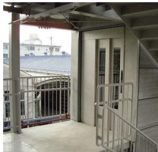
▲改修後(増設されたエレベーター)
