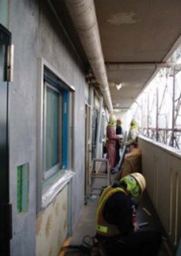
▲改修工事の状況
