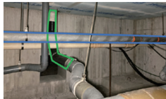
— 給水管更新部 — 排水管更新部
