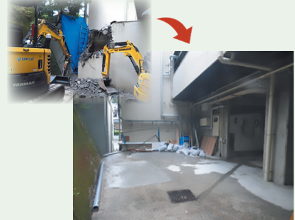
コンクリート製受水槽を解体し、防災・イベントスペースに。
