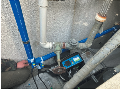
EF接合した高性能ポリエチレン管
