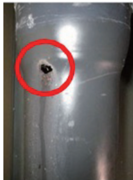
排水管の劣化状況 (穴が開いた配管)
