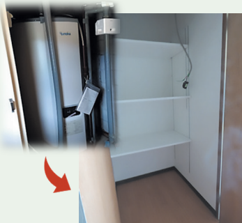
撤去した電気温水器置場をバントリーに改修。
