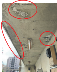
廊下天井部分
