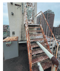
屋上 ELV 機械室に至る階段
