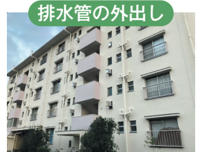
排水管の外出し
