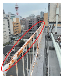
屋上の手すり
